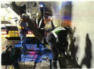
【監査廊復旧状況】
