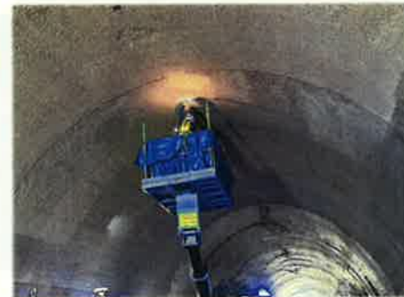
[はく落防止剤塗布作業状況]
