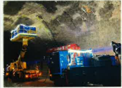
[注入孔削孔状況]
