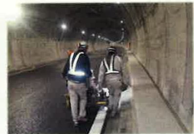
【路面標示施工状況】
