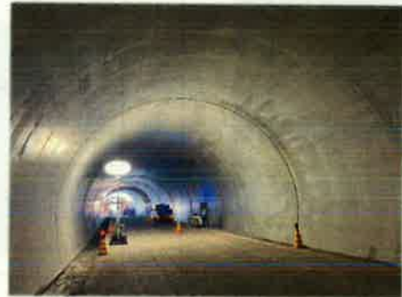
【コンクリート打設後】
