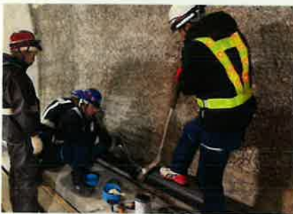
【配水本管 施工中】
