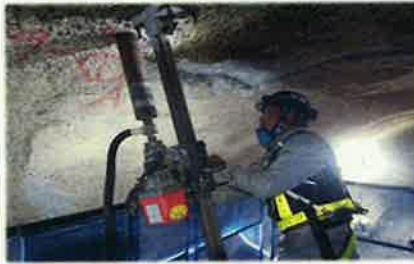
[ボーリングコア削孔状況]
