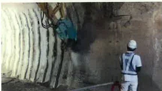
[覆工切削作業状況 (動画)]
