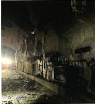
[トンネル内部の焼損状況]
