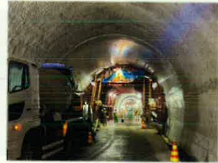
【コンクリート打設状況】
