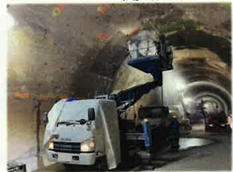
[ウォータージェットによるはつり状況]
