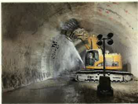
[覆工切削作業状況]
