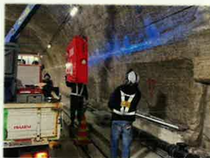
【消火栓 施工中】
