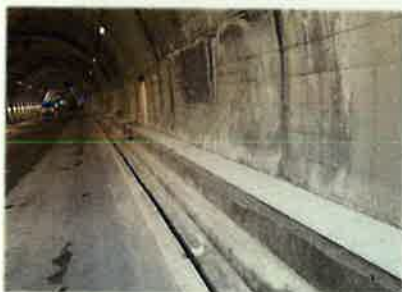
【配水本管 施工後】
