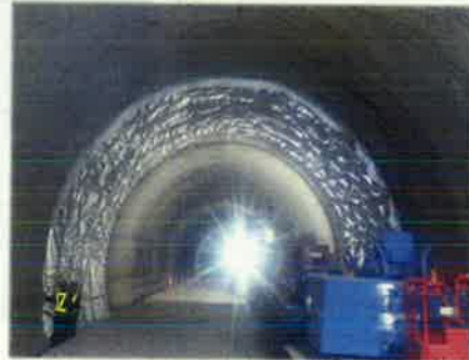
【防水シート設置状況】
